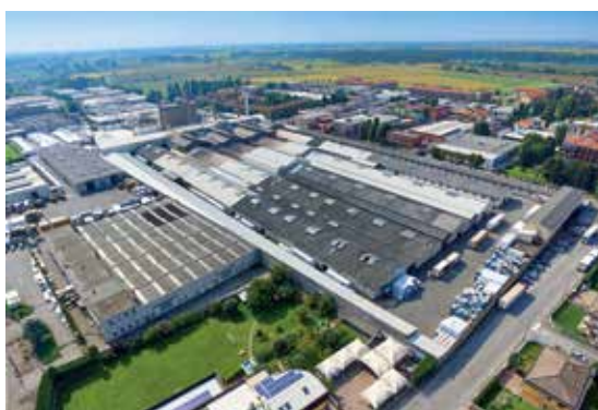
Werk Trezzano, Italien
