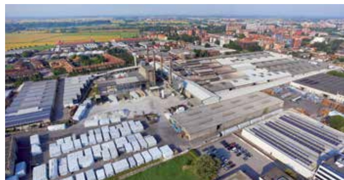
Werk Trezzano, Italien
